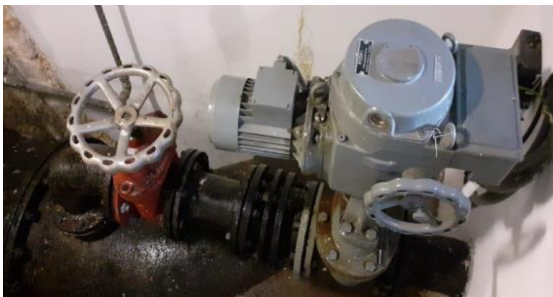
Potrubí DN150 sanačního průtoku ve strojovně
