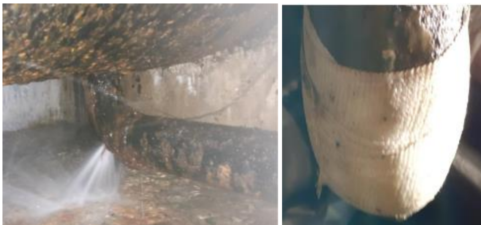
Havárie odkalovacího potrubí 02/2022 a provizorní oprava
