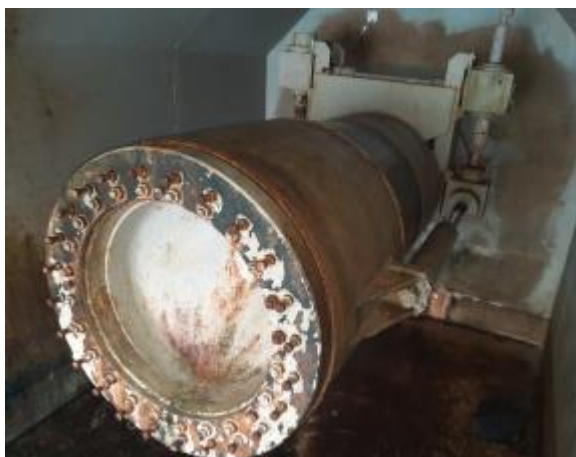
Provozní uzávěr regulační – rozstřik DN600 v komoře
