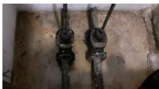
Oprava odkalovacího potrubí DN50, umístění stávajících šoupat
