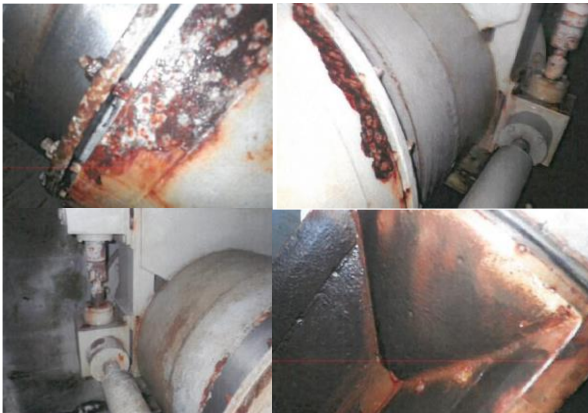
Detaily stavu rozstřikovacích uzávěrů
